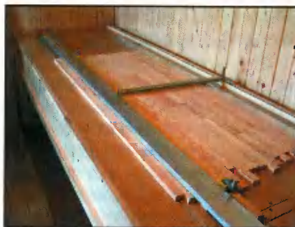
В качестве направляющей для продольного резания можно использовать штукатурное правило
