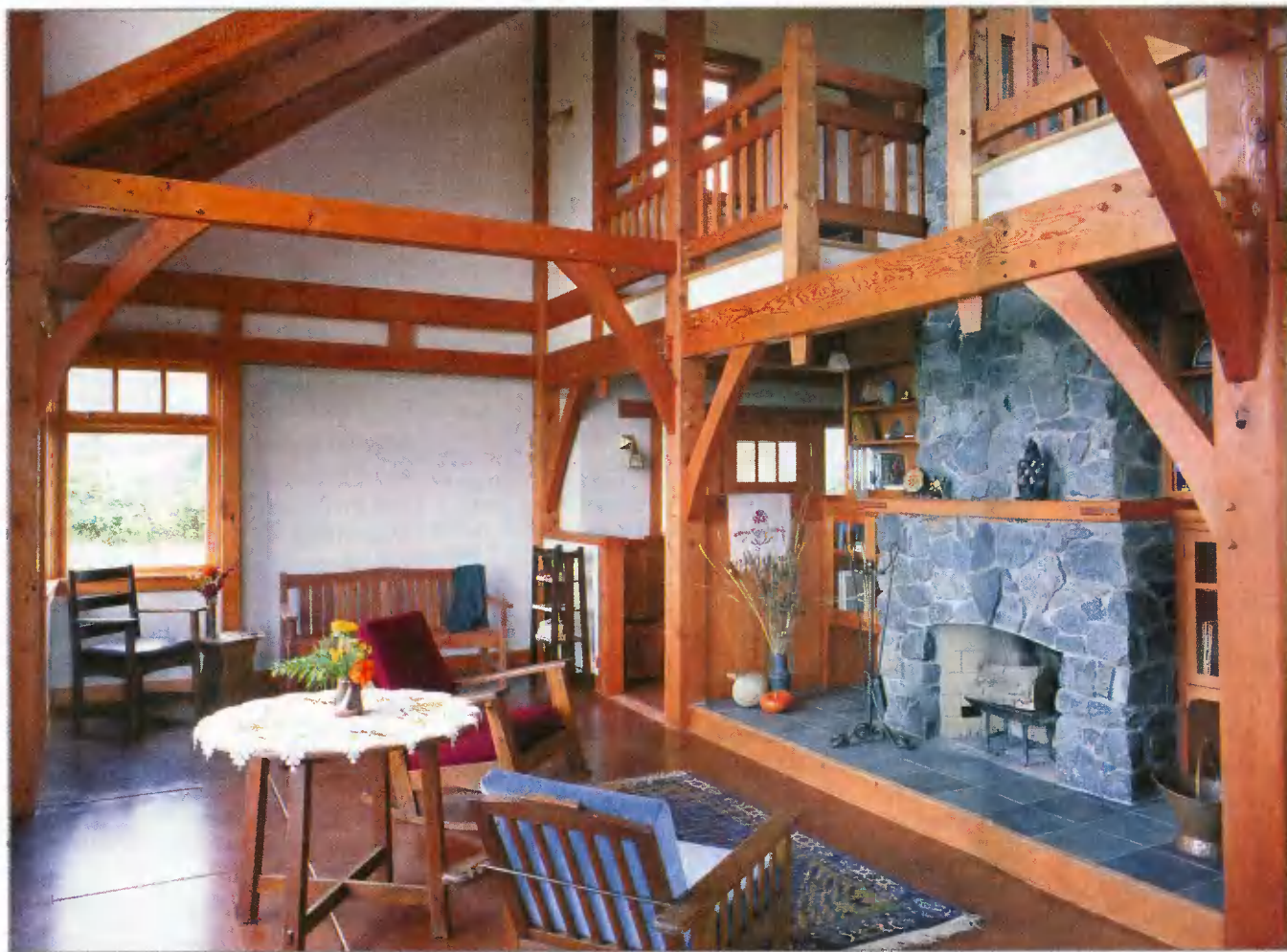
Вокруг гостиной по стенам тянутся двоянные балки. Этот элемент повторяется в лестничном ограждении второго этажа и линиях окон. Снимок сделан в направлении стрелки Е на плане
