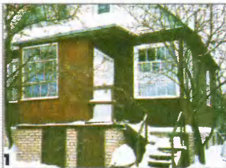
Дом на столбах. Легкое крыльцо с лестницей выгалькивается из грунта более интенсивно, чем основное строение
