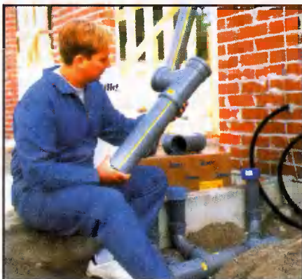
Канализационную систему легко смонтировать из полипропиленовых элементов Uponor НТР
