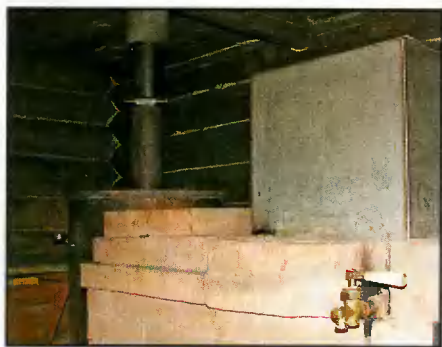
Благодаря большому объему бака и тепловой инерции каменки, горячая вода в доме не переводится практически асбестом
