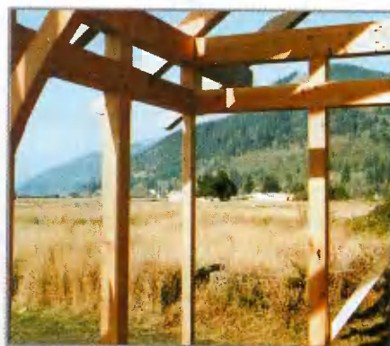
Каркас угла дома. Установка угловых окон потребовала перенесения опорных балок на 1,2 м от угла.
